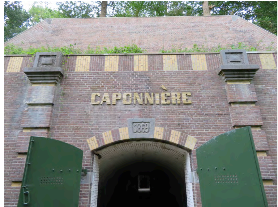
Afb. 9: Fort Rijnauwen: de toegang tot de caponnière (foto auteur)
