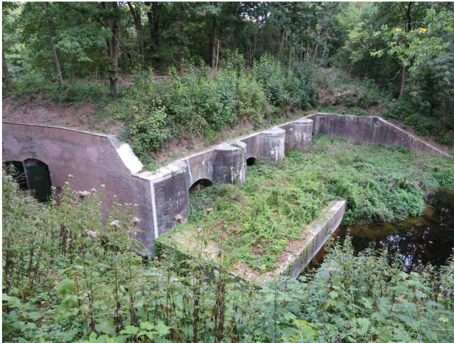
Afb. 8: De frontcaponnière van fort Rijnauwen. De kazematten worden door een vleugelmuur beschermd tegen direct vuur uit het veld. De caponnière zelf is met een gracht afgescheiden van de rest van het fort (foto auteur)
