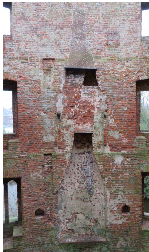
Afb. 5: Overzicht van de haardpartij in de oostgevel. Hierin zijn volop reparatiesporen zichtbaar uit verschillende fases. In het muurwerk zijn twee rookkanalen gevonden. Op de tweede verdieping heeft hier geen haardpartij gelegen. (afb. auteur)
