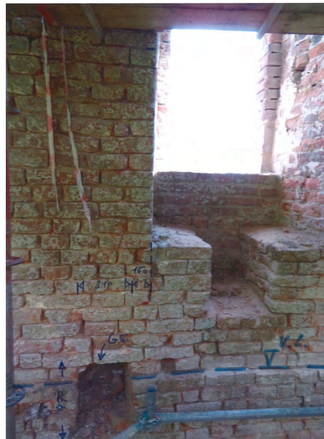
Afb. 20: Overzicht van het muurwerk waarin de sparing G5 is aangetroffen. (afb. auteur)
