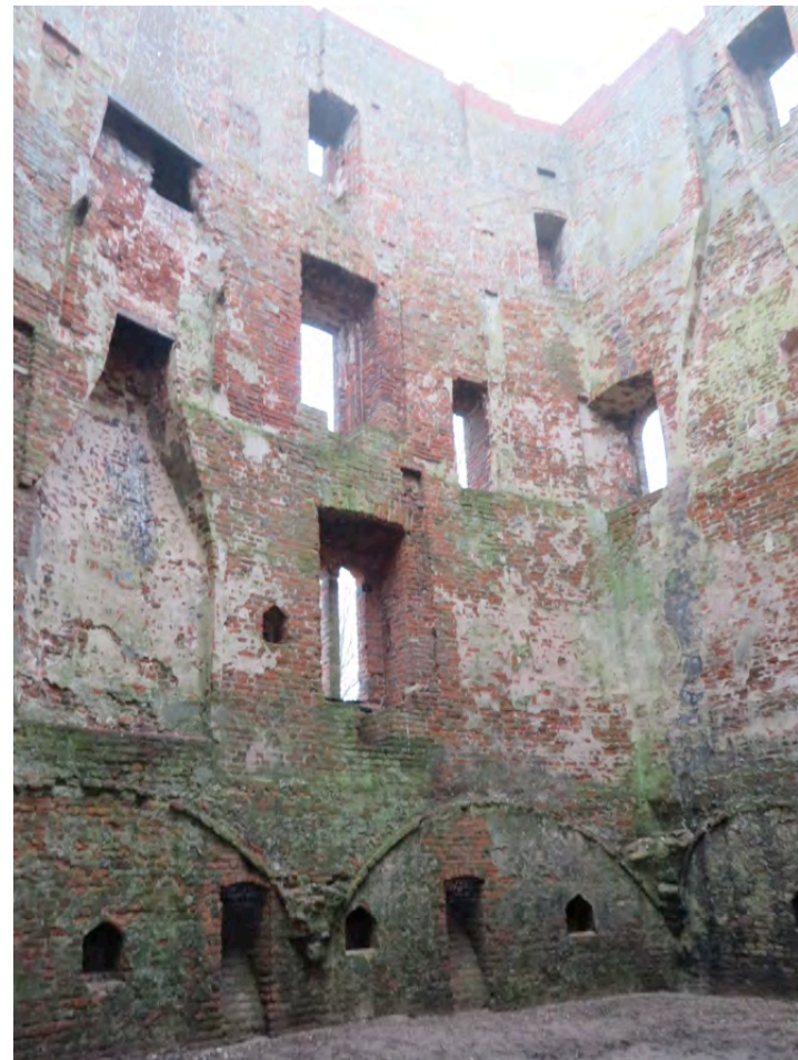
Afb. 4: Aanzicht van de binnenzijde van de oostgevel (afb. auteur)
