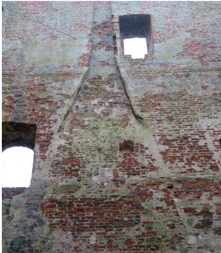
Afb. 9: Overzicht van de haardpartij in de zuidgevel. Bovenin is zichtbaar hoe dicht het rookkanaal langs de gevelopening is gelegd. Het metselwerk hier is al een keer afgebroken en hersteld met kleine stenen. Ze hebben hetzelfde formaat als de stenen die gebruikt zijn in de zijwangen van de haard, waarvan restanten zichtbaar zijn op de eerste verdieping. Ook is hier de kaarsnis zichtbaar, deze was dichtgemetseld en is tijdens het restauratiewerk geopend.
