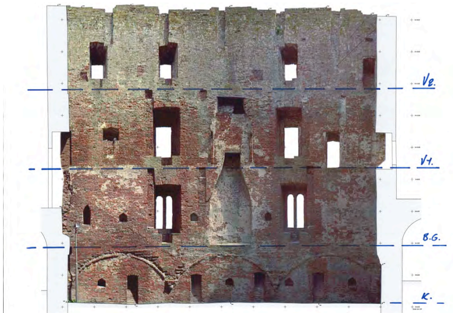
Afb. 3: Aanzicht van de binnenzijde van de oostgevel met daarin de benamingen van de bouwlagen aangegeven: kelder, begane grond, eerste verdieping en tweede verdieping. (afb. archief SMB)
