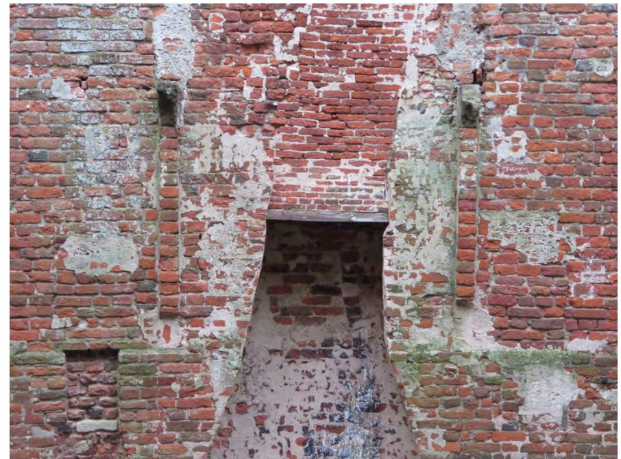
Afb. 10: Detail van de haard op de eerste verdieping. De twee zijwangen van de haard zijn duidelijk zichtbaar. De stenen hebben dezelfde dikte als het omliggende metselwerk. Bovenop de zijwangen zijn consoles geplaatst van Trachiet. (afb. auteur)
