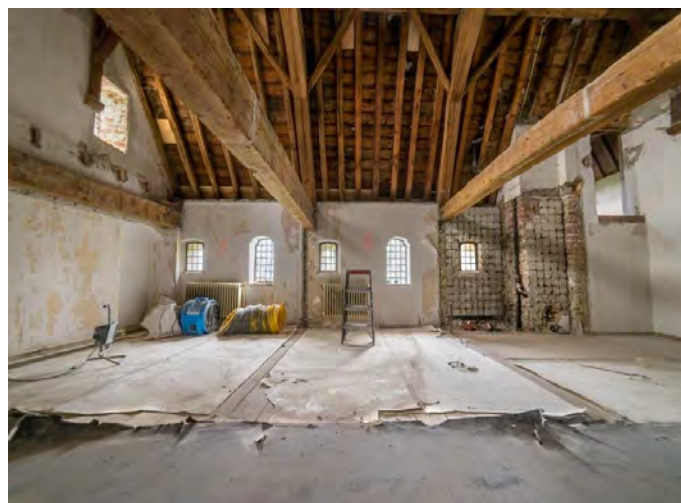
Kasteel Radboud: de zolder na demontage
