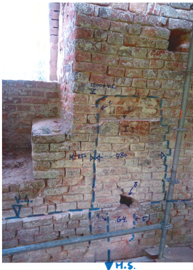
Afb. 19: Overzicht van het muurwerk waarin de sparing G4 is aangetroffen. Met I3 is de inkassing aangegeven. Bij MS sluit een muurstijlsleuf
