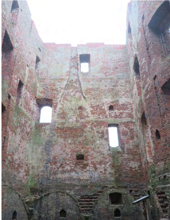
Afb. 7: Aanzicht van de binnenzijde van de zuidgevel (afb. auteur)
