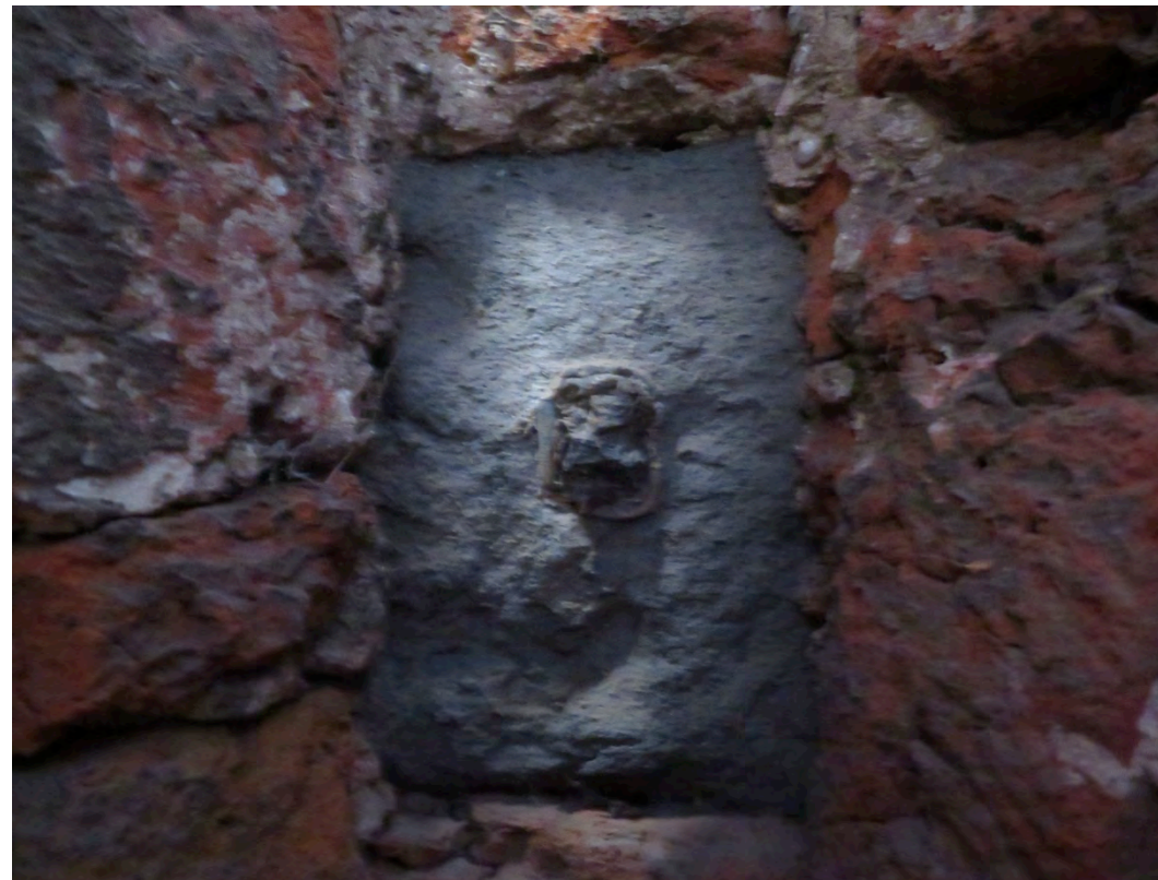
Afb. 29: De sluitsteen bovenin de nis, met in het hart de loden mantel met de stop of het ijzer onderdeel. (afb. auteur)
