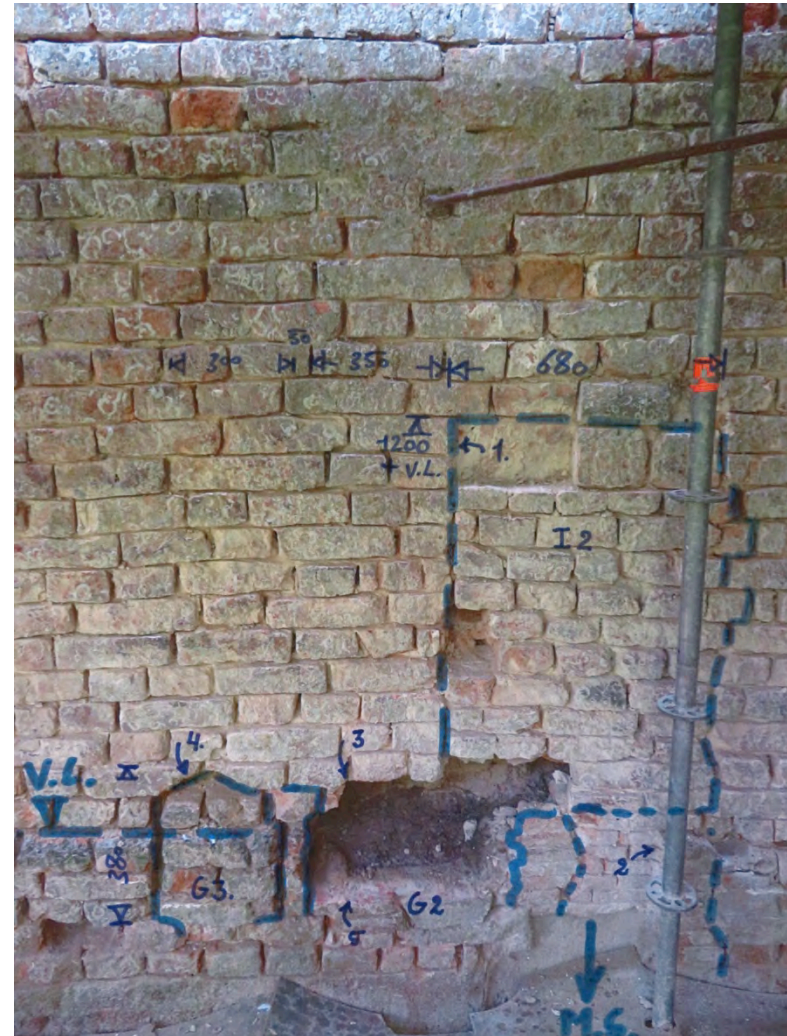
Afb. 17: Overzicht van het muurwerk waarin de sparingen G2 en G3 zijn aangetroffen. Met I2 is de inkassing aangegeven. Bij MS sluit een muurstijlsleuf aan. (afb. auteur)
