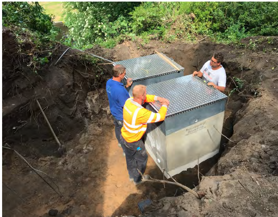
Kronenburgertoren: plaatsen van de putten voor het riool en het water
