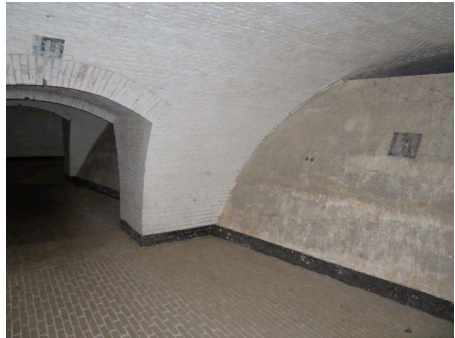
Afb. 11: Fort Rijnauwen: het interieur van de kazematten met de schuingeplaatste, betonnen achterwand (foto auteur)
