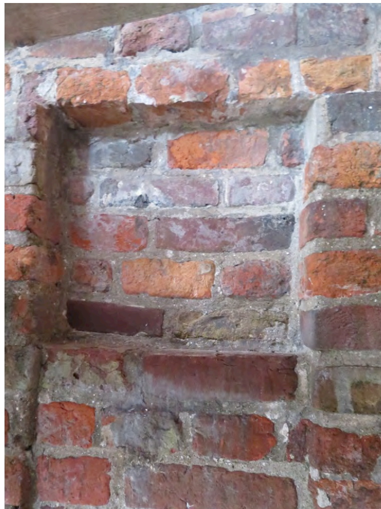
Afb. 24: Een van de balksparingsen met aansluitende muurstijlsleuf in de westgevel. Het gaat hier om restauratiewerk. (afb. auteur)
