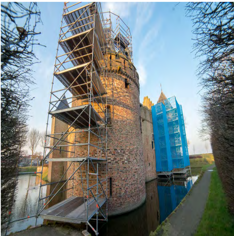
Kasteel Radboud: onderhoudswerkzaamheden aan het casco
