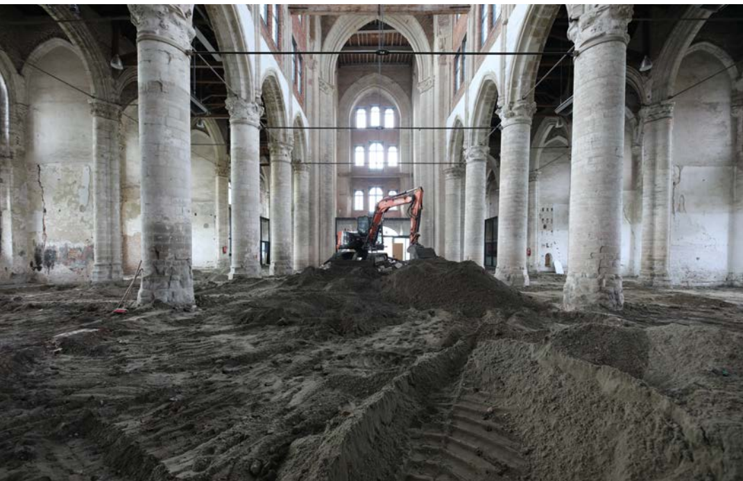
Foto Frank van Rooijen, aanbrengen van nieuw zandbed
