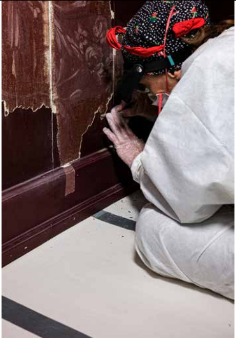
Het vrijleggen van de schildering op de lambrisering in de Rode Kamer. Foto Monumentenbezit, 's-Graveland
