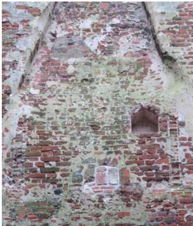
Afb. 72 De haardpartij op de eerste verdieping in de zuidwand. Hierin is ook de aangetroffen kaarnis zichtbaar (foto Monumentenbezit).
