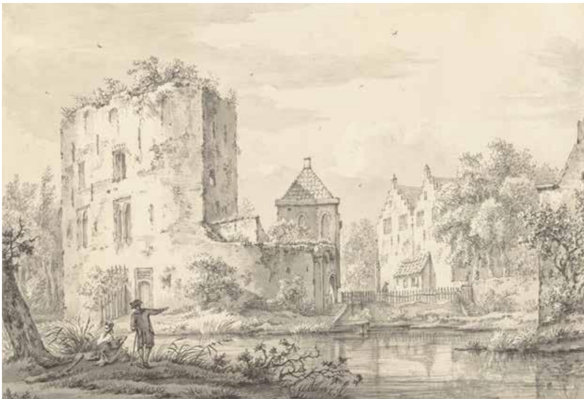
Afb. 9 De situatie in 1792 getekend door Carel Lodewijk Hansen. De donjon is inmiddels veranderd in een ruïne. Achter de staande figuur is de doorgang in de oostgevel zichtbaar. Boven de ringmuur steekt, direct naast de donjon, het dak van een van de aanbouwen uit. Rechts, is de grote houtvesterswoning zichtbaar (collectie Rijksmuseum inv. nr. RP-T-1897-A-3187).
