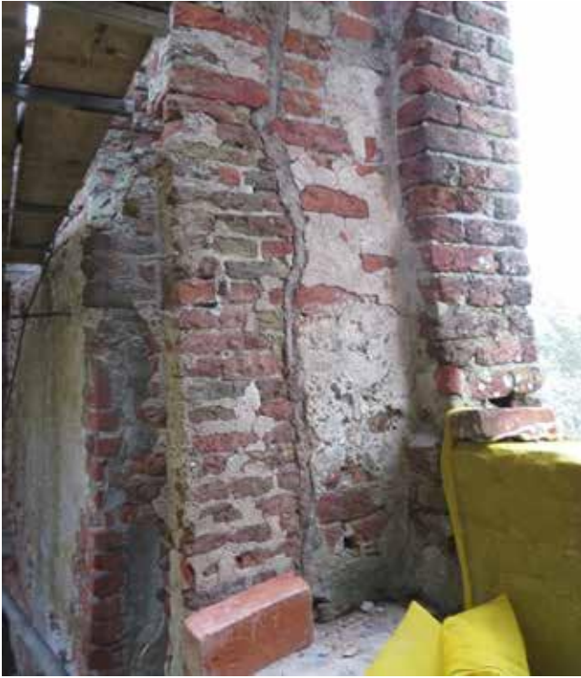
Afb. 73 Het aangeheelde metselwerk tussen het rookkanaal en de gevelopening op de tweede verdieping in de zuidwand, aangegeven met de b. op afbeelding 71 (foto Monumentenbezit).
