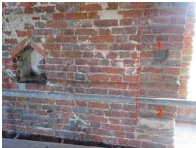
Afb. 61 Foto van een van de muurstijlsleuven in de oostgevel op de begane grond (zie afb. 59 voor de positie). De stippellijn geeft de zijkant aan van de sleuf die direct naast de gevelopening in het metselwerk is uitgehakt. De positie van de muurstijlen werd afgestemd op de bestaande gevelindeling. In de sleuf is het gat te zien waar de verankering van de muurstijl doorheen liep (1). Onder in de sleuf is nog het restant te zien van de natuursteen console (2) (foto Monumentenbezit).
