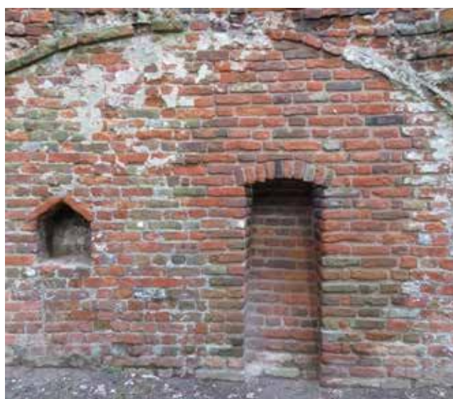
Afb. 79 De dichtgezette doorbraak in de oostgevel in september 2020. De lichtnis werd hierbij gereconstrueerd. Hier werden dezelfde materialen gebruikt als in de noordgevel met dezelfde aftekening als resultaat (foto Monumentenbezit).
