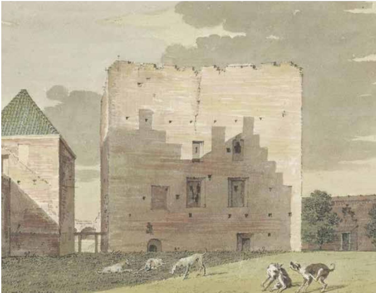
Afb. 10 De westgevel van de donjon rond 1730. Aquarel in kleur door C. Pronk van Het Jagthuis Teilingen bij Sassenheim. De rondboog van de doorgang naar de kelder is net zichtbaar. De gevelopeningen op de tweede verdieping zijn volledig dichtgemetseld. In het muurwerk van de donjon zijn kortelingaten zichtbaar (collectie Noord Hollands Archief NL-HlmNHA_1100_KNA006003285).
