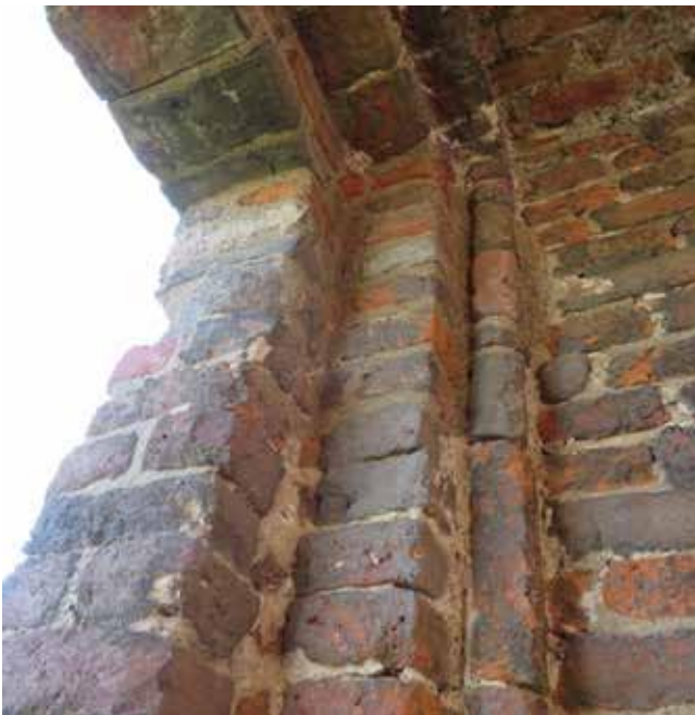
Afb. 49 De geprofileerde omlijsting rond een gevelopening op de eerste verdieping (foto Monumentenbezit).
