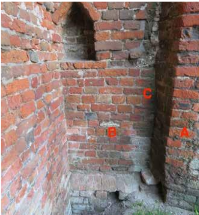
Afb. 26 De ontmoeting tussen de donjon (A) en de ringmuur (B) aan de noordzijde. Tussen de pijler van de ringmuur en de donjon zit een sprong. Tussen beiden zit een duidelijke naad (C). Aan de zuidzijde vormt deze ontmoeting een net en strak geheel, zonder sprong (foto Monumentenbezit).
