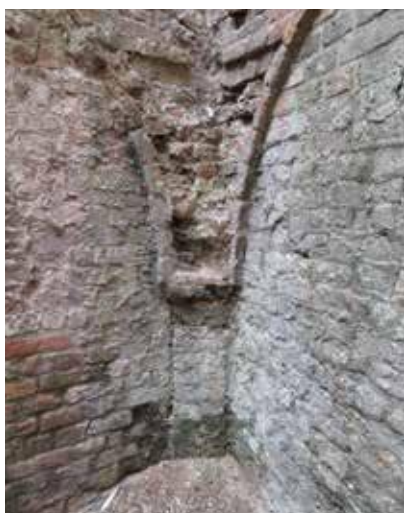
Afb. 38 In de noordwesthoek, ter plaatse van de keldertrap, rust de hoek van het gewelf op een penant. Een dergelijk penant is in de andere drie hoeken niet aanwezig (foto Monumentenbezit).
