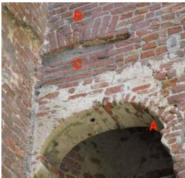
Afb. 45 Detail van de entree van het trappenhuis op de begane grond. De rondboog met de twee gemetselde consoles (A) bestaat uit steentjes van 4,5cm dik. Erboven is de korfboog zichtbaar van de oorspronkelijke toegang (B). De linkerhelft is nog geheel opgetrokken in kalkmortel, het voegwerk van de rechterhelft is vernieuwd. Aan de binnenzijde is de grove kalkmortel nog zichtbaar. Onder de korfboog ligt de natuursteen plaat (C). Aan de binnenzijde van het trappenhuis is hier het gewelf op opgelegd (foto Monumentenbezit).
