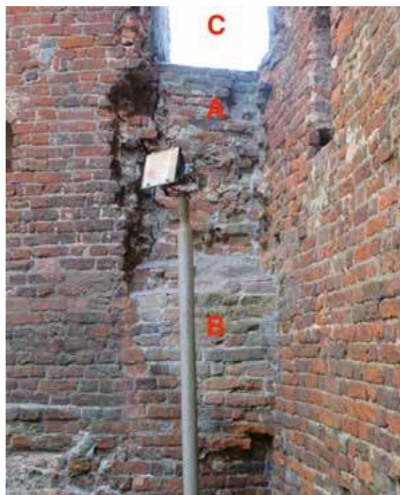
Afb. 32 In de noordoosthoek is een vlak gebroken metselwerk zichtbaar (A). Dit is waarschijnlijk het restant van de ringmuur dat in de donjon grijpt. Vroeger was dit weggewerkt in het metselwerk van de noordwand (B). Bij het uitbreken van de bovengelegen doorgang (C) is het metselwerk van de ringmuur bloot komen te liggen (foto Monumentenbezit).
