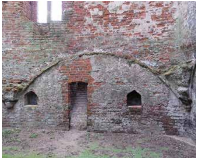
Afb. 36 Een lichtnis met daarnaast twee kaarsnissen en de aanzetten van het gewelf in de zuidoosthoek van de kelder (foto Monumentenbezit).
