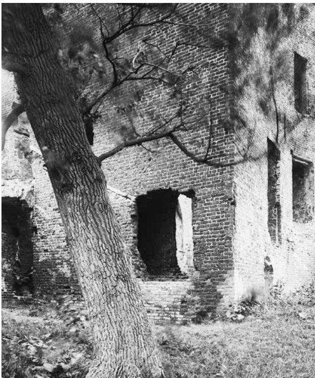
Afb. 76 De doorgang die in de noordgevel werd gebroken. Foto van rond 1900 (foto collectie RCE inv. nr 37.735).
