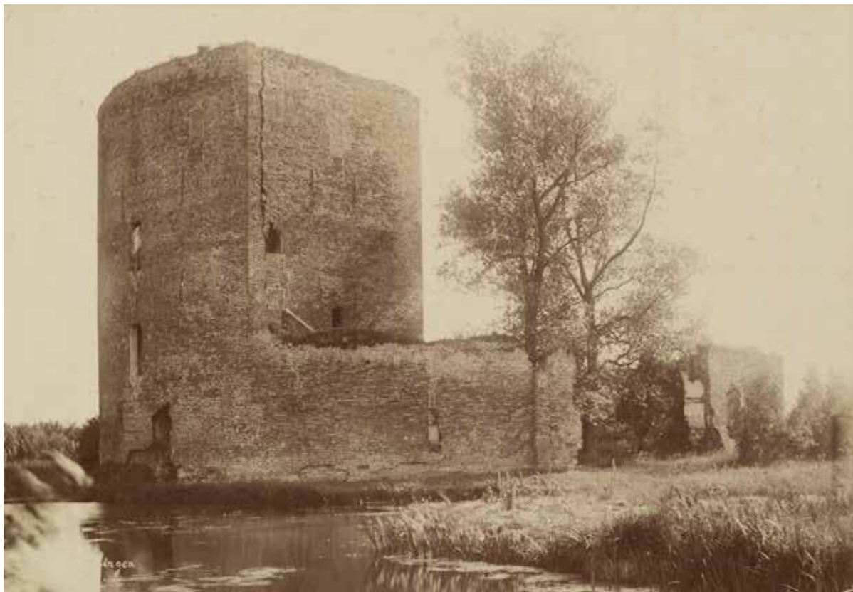
Afb. 34 De scheurvorming op de noordoosthoek rond 1900 (foto collectie RCE inv. nr. OF-04973).
