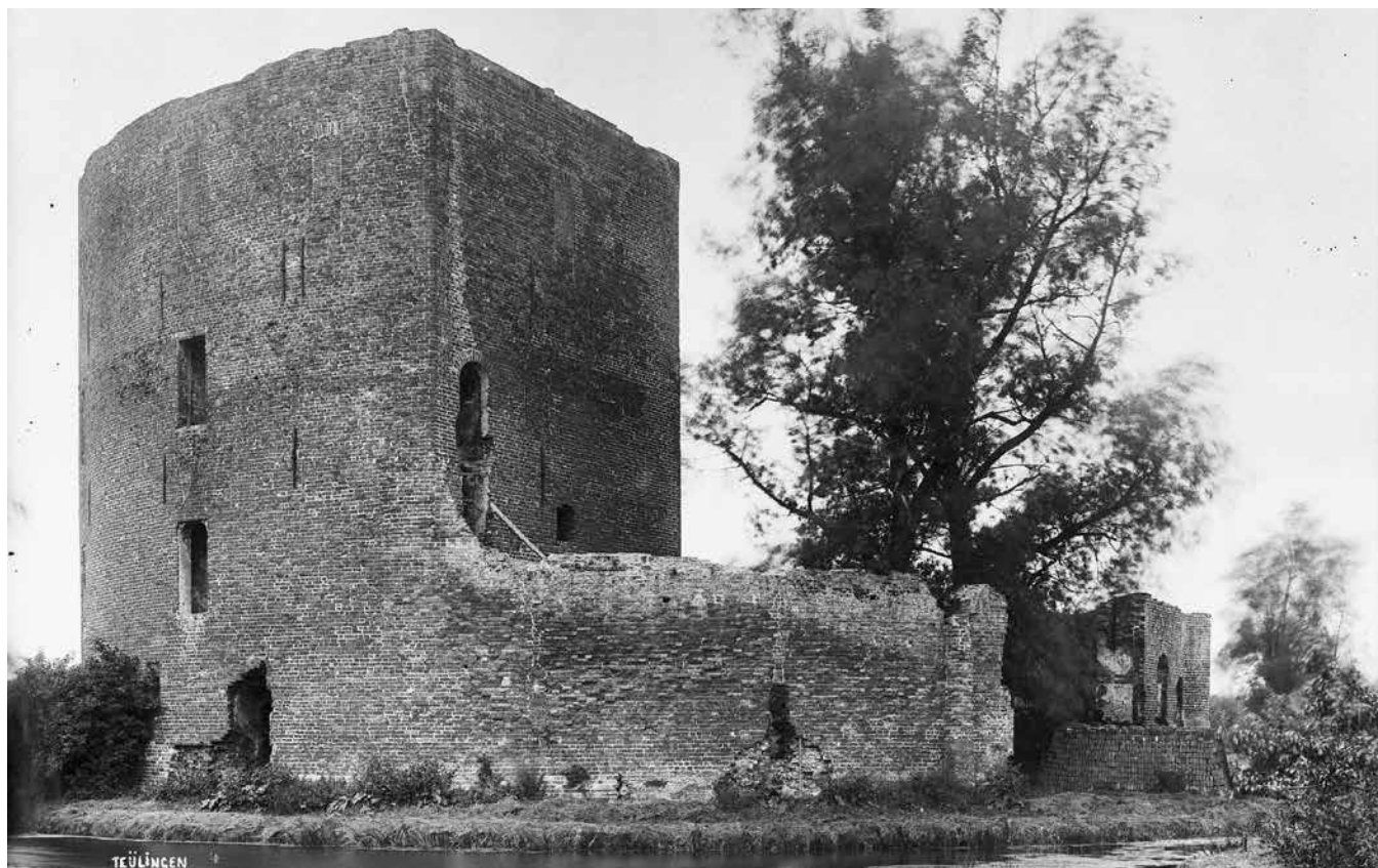
Afb. 78 Foto van rond 1900. De doorgang die in de oostgevel werd gebroken (foto collectie RCE inv.nr. 38.200).
