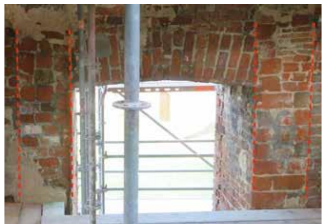
Afb. 74 Twee dichtgezette muurstijlsleuven aan weerszijden van een gevelopening in de westwand op de begane grond aangegeven met stippellijnen. Positie aangegeven op afbeelding 60 (foto Monumentenbezit).
