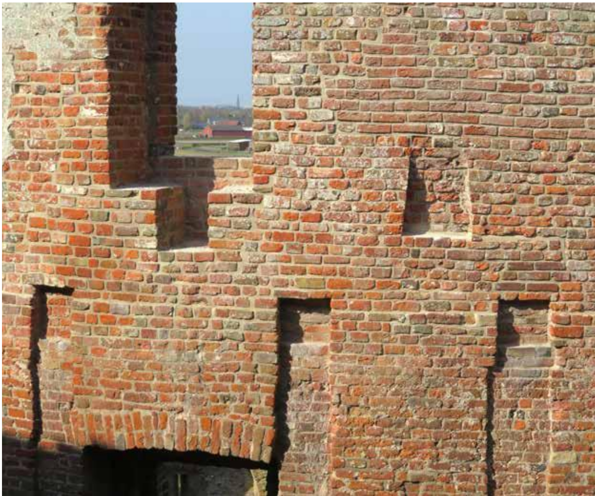
Afb. 80 Zicht op de balkgaten in de westwand ter hoogte van de tweede verdiepvingsvloer, na afronding van de werkzaamheden in 2019. Het bovenste deel van de inkassing kwam tijdens de werkzaamheden bloot te liggen. Dit is zo gelaten. De inkassing is in 1384 gemaakt om een bestaande balk te verwijderen zodat deze kon worden hergebruikt (foto Monumentenbezit).
